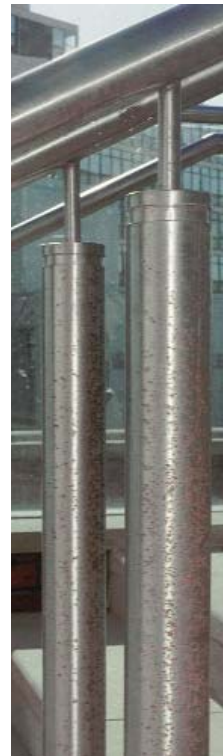
La contaminación por oxidación del hierro, durante la vida en servicio del acero inoxidable es antiestético. Se puede eliminar con tiempo y con un gasto económico importante.
